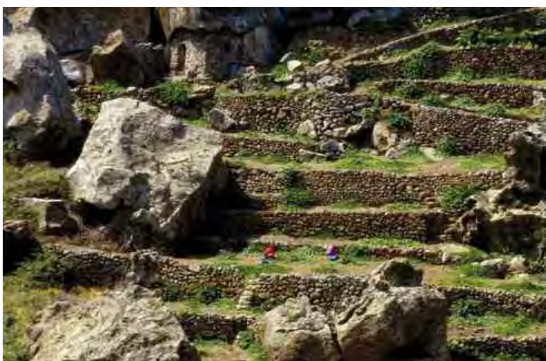
Fig. 2.4.2.12 Cappereto imponente con muretti a secco in pietra lavica e con blocchi anche di notevole dimensione (Isola di Pantelleria).
