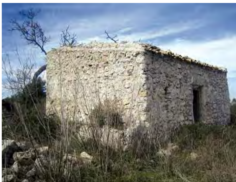
Fig. 2.3.5.11 Casedda in pietra a facciavista e tetto in coppi ad un piovente.
