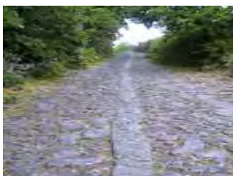
Fig. 2.3.2.17 Pavimentazioni dei percorsi trasversali in pietra lavica (semplice, in acciottolato; mista, in acciottolato e basole; con doppia basola).
