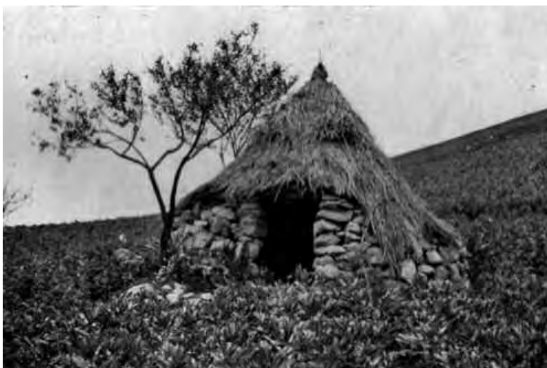
Fig. 2.3.5.12 Pagliaro con basamento in pietra a secco, Sutura (da VALUSSI, 1968).
