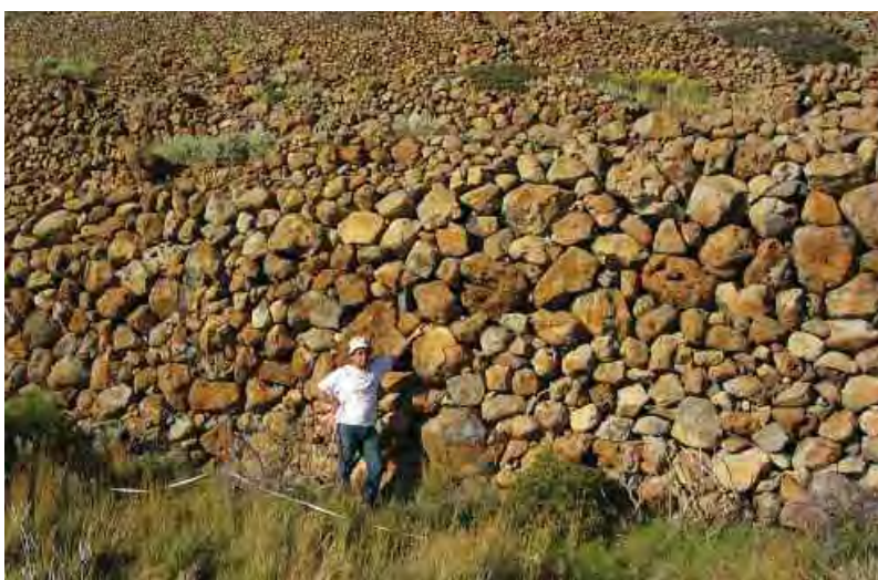
Fig. 2.4.2.11 Costruzione imponente in pietra lavica con blocchi di notevole dimensione (Filicudi, Isole Eolie).
