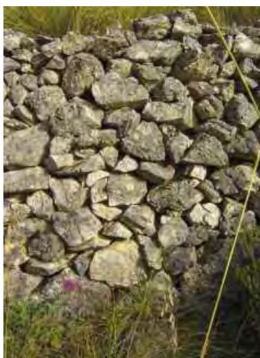
Fig. 2.4.2.4 Costruzione con pietra calcarea irregolarmente lavorata su più facce, di dimensioni diverse (Sàgana, monti di Palermo).
